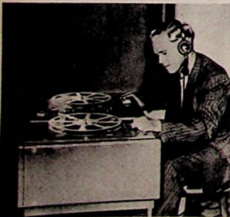
16-mm-Schmalfilmgeber der Askania-Werke nach Dr. Schunack für aktuelle Sendungen des Berliner NWDR, aufgestellt im Studio der Fernsehübertragungsstelle der Deutschen Bundespost in Berlin-Tempelhof
